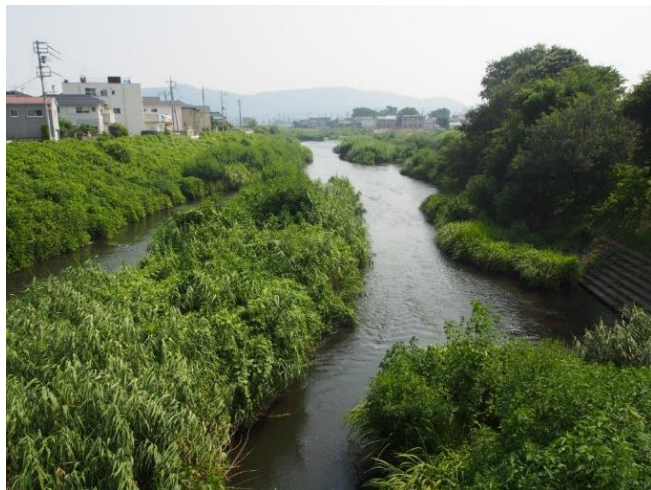
2013年8月 立堀橋より下流側
