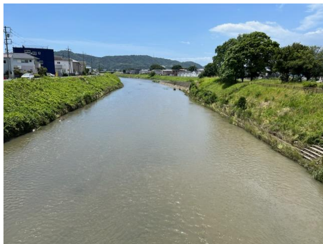
2023年8月 立堀橋より下流側
