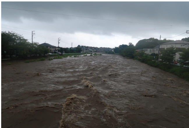
写真1 観音橋付近の様子
